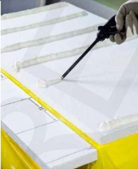
Según el fabricante existen varias formas para la aplicación del adhesivo en las placas
