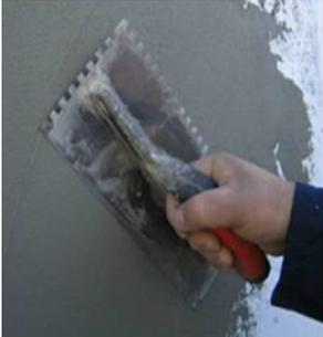
previo a la colocación de la malla, las placas se revisten con una primera capa de mortero, llamada capa base, de aproximadamente 1 a 2 mm de espesor.
