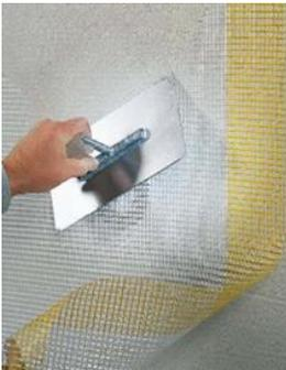
La capa de **Sto Basecoat** reforzado con la **Sto Malla de Refuerzo** es considerada la primera barrera impermeable en la pared, resiste el agua de lluvia y viento.
