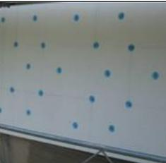
para fijar las placas aislantes al soporte se recomienda, además del adhesivo, el uso de una fijación mecánica complementaria compuesta de tacos de plástico con cabeza circular.
