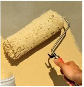
Una vez aplicada la 2ª capa de mortero se esperan 24h y se aplica la imprimación, para:
