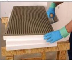
extender con llana dentada el adhesivo por todo el reverso de la placa.
